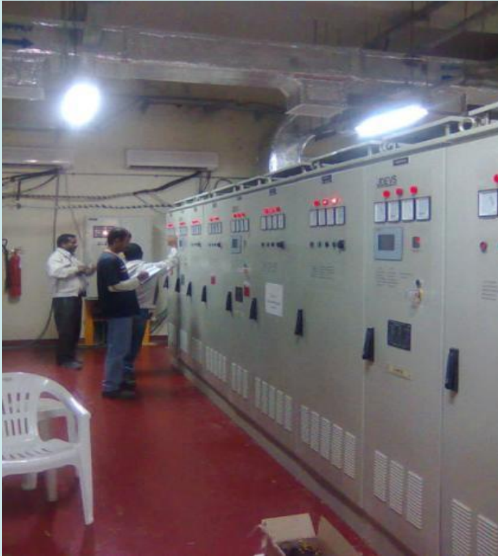
فازهای ۹ و ۱۰ خشکی پارس جنوبی
