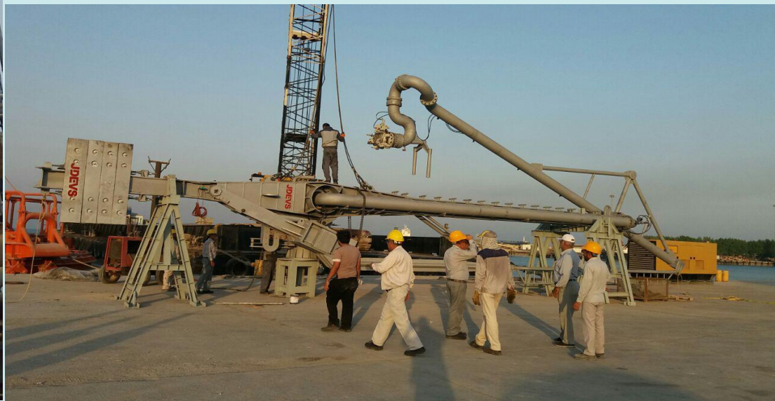
بازوی بارگیری نصب شده در جزیره خارگ
