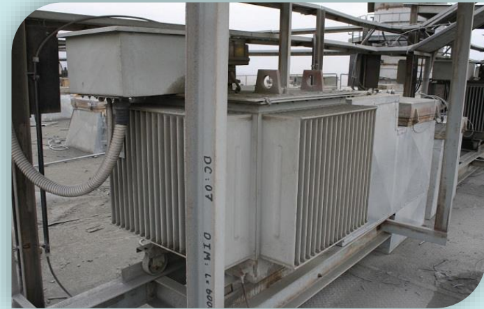
ترانس رکتیفایرهای کارخانه سیمان تهران
