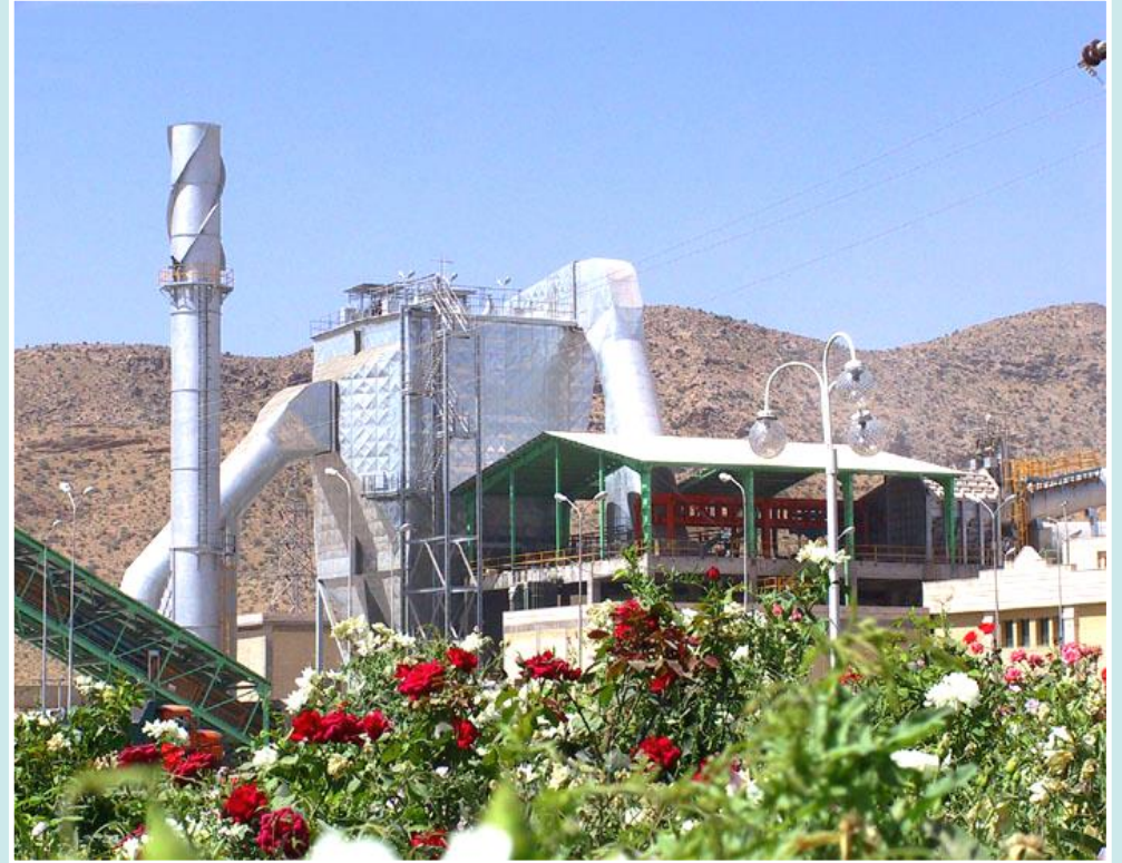
Grate Cooler ESP – سیمان داراب
