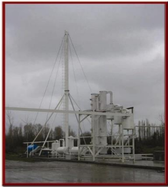
طراحی و نظارت بر ساخت سیستم کنترل آلودگی هوا در بخش تبدیل ضایعات کشتارگاه مرغ
