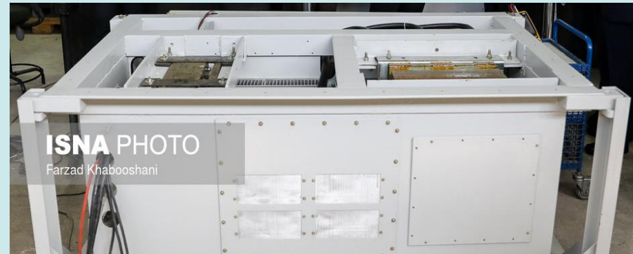
مبدل برق سه فاز و شارژ باتری
